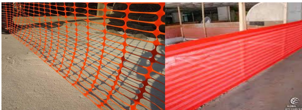
Figura 4 – Telas plásticas sinaleiro.
